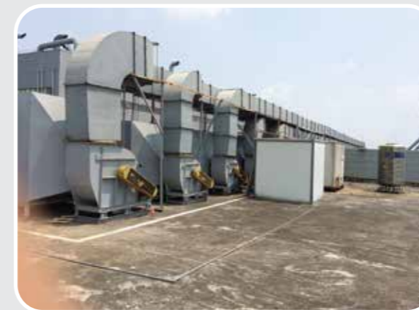
Cung cấp và lắp đặt hệ thống lọc khí cho phòng sạch- Công ty MOBASE-HÀN QUỐC (KCN Yên Phong-BắcNinh)
