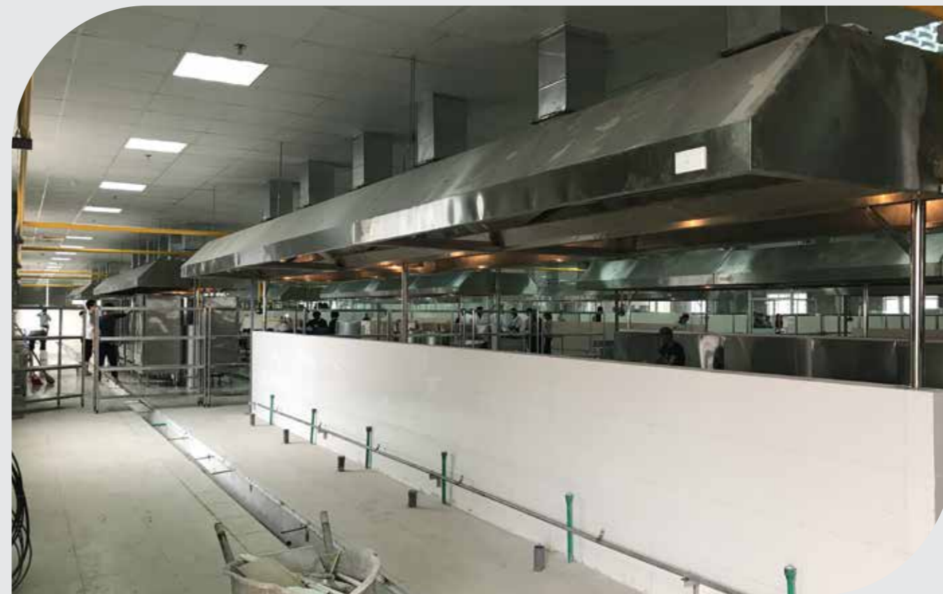
Hệ thống hút mùi bếp cho nhà máy sản xuất suất ăn công nghiệp (4000 suất ăn /ngày) KCN Quế Võ-Bắc Ninh
