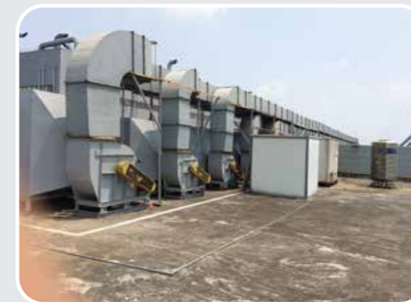
Cung cấp và lắp đặt hệ thống lọc khí cho phòng sạch- Công ty MOBASE-HÀN QUỐC (KCN Yên Phong-BắcNinh)
