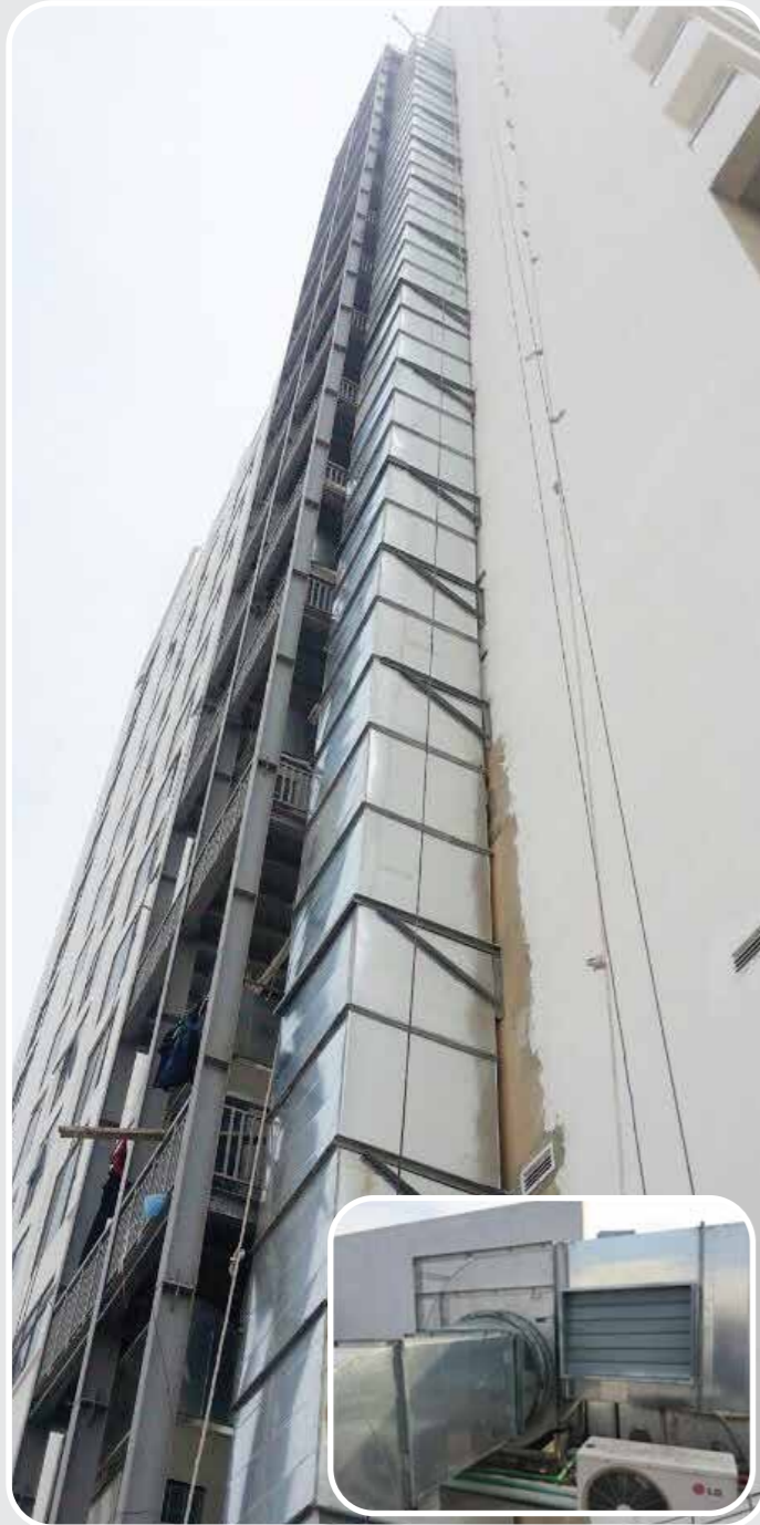
Hệ thống tăng áp, hút khói Chung cư CT12-Văn Phú-Hà Đông
